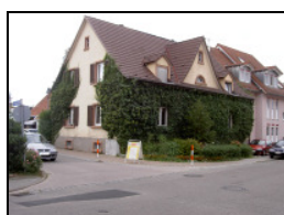
EFH in Bad Krozingen
